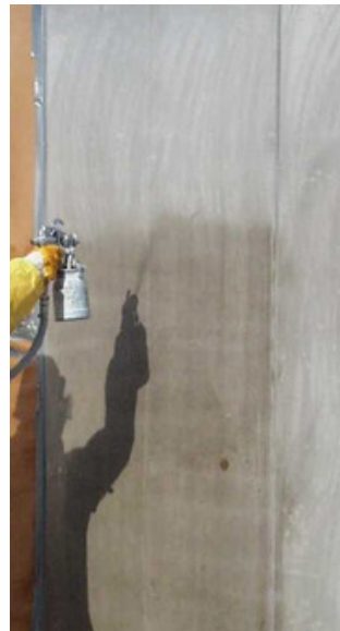
Während der ersten Applikation erscheint die Fläche feucht (Dunkelfärbung).
